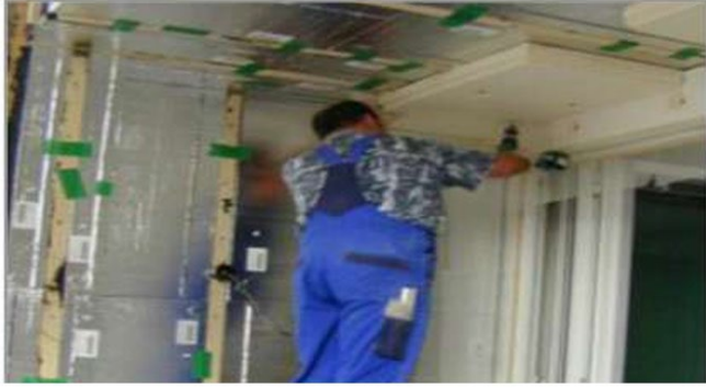
شكل (4): تركيب مادة ((VIPs لسقف وجدران المبنى (أكرم فاروق وآخرون، 2018، ص. 38)
